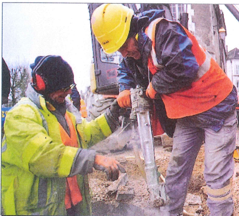
BTP. Huit des 10 premières entreprises du classement du secteur du BTP sont les mêmes que l'an passé. PHOTO D'ARCHIVES FLORIAN SALESSE.
