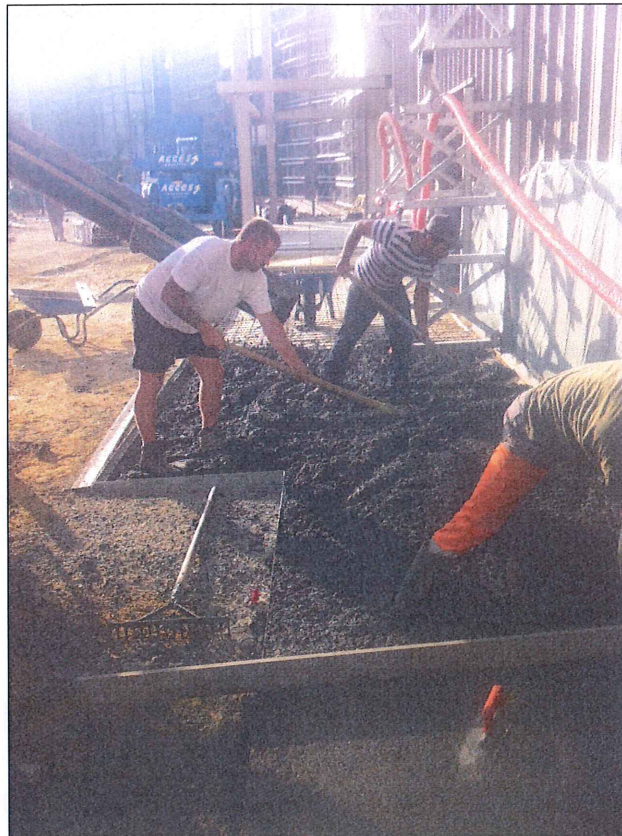
Chantier Jupiter – St Geneviève des Bois
