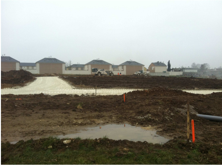
Le traitement, puis après la réalisation
