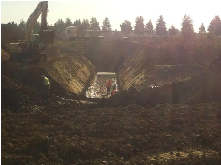
Nous devons poser des ouvrages entre un bassin et un exutoire : des TALUS pour ne pas oublier la protection de nos ouvriers. Ceux ci ont été préparés par le bureau d’étude bien avant le démarrage de ces travaux, en même temps que le projet général. Comme quoi la sécurité n’est pas le fait du hasard.
