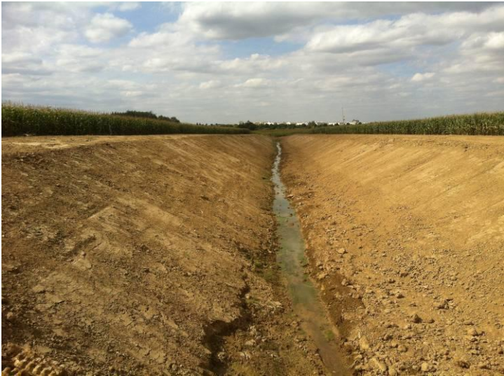
Ce fossé a été réalisé à l’aveuglette dans l’eau avant que nous puissions abaisser le point bas. Merci au GPS et à la dextérité de leurs utilisateurs.
