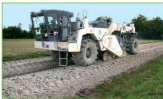
Origny-le-Sec (Aube) : le pulvimixeur mélange matériaux du site, LHR et eau.
