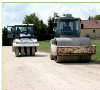
Origny-le-Sec (Aube) : deux compacteurs (à pneus et vibrants) assurent la régularité de la future chaussée.
